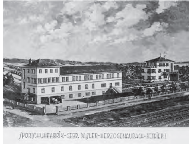
12 Fabrikgebäude in der Kreuzgasse 2, nun „Betrieb I“, nach allen Umbauten 1938 – angrenzend das Dreifamilienhaus, errichtet 1932/33 (Aufnahme ca.1939)
