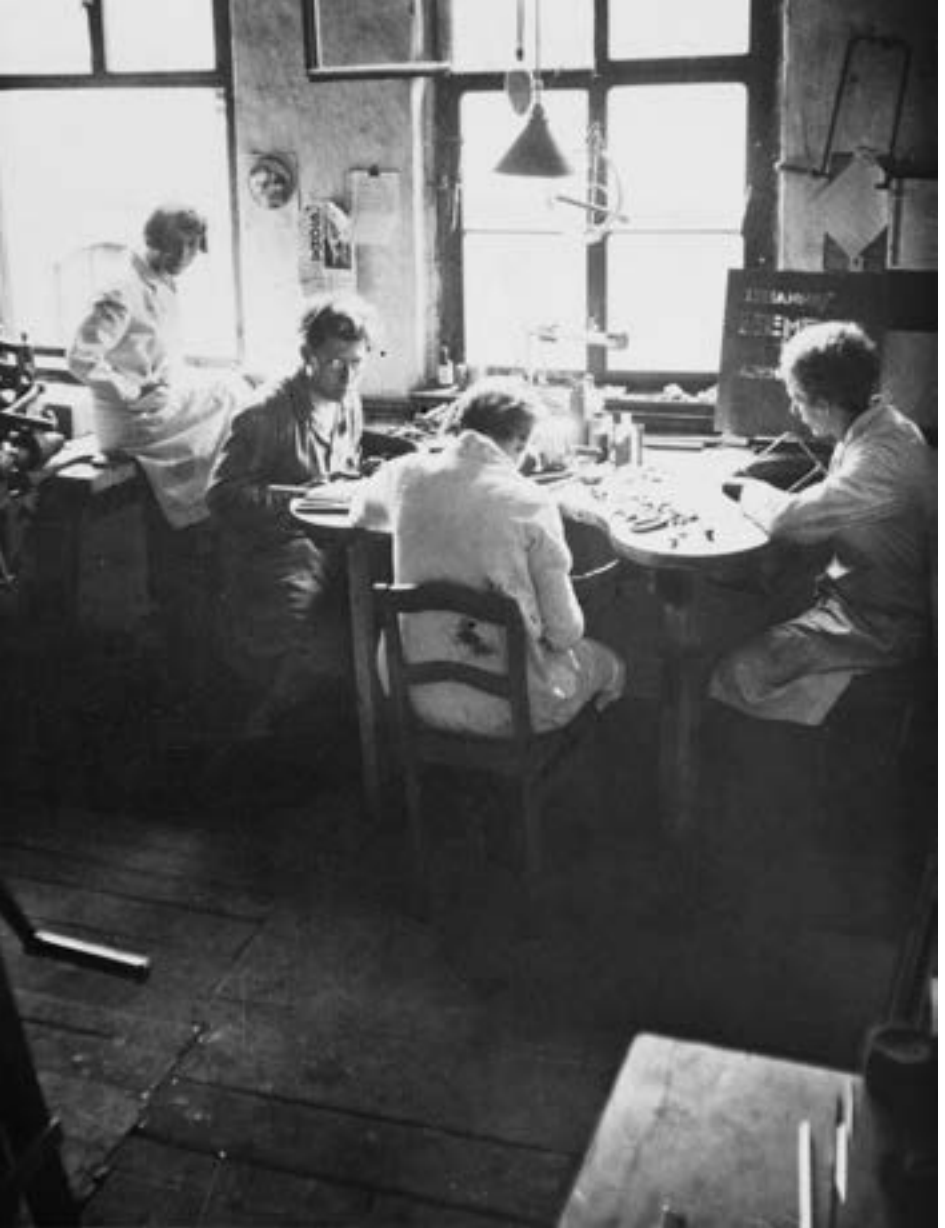
Blick in die Metallwerkstatt des Bauhauses in Weimar, um 1924/25. (Foto: unbekannt)
